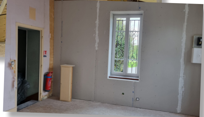
Rénovation de la mairie
